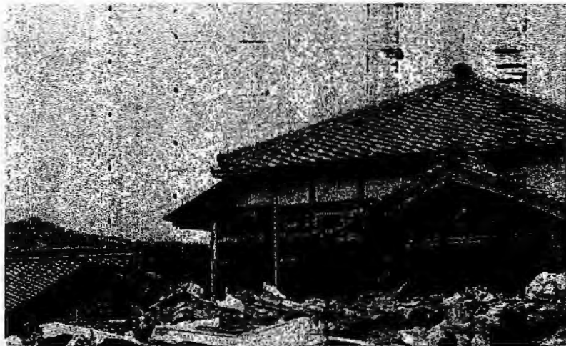
山口県玖珂郡伊陞に墜落したロンサムレディー号の破片を、墜落地点から約800メートル離れた国道に面した公会堂前に、GHQの指示に基づいて村民が集めたもの[工藤洋三氏提供]
